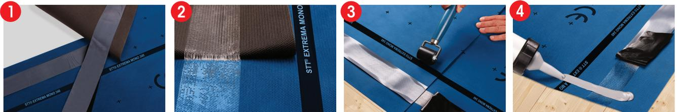
1 Beide Liner werden gleichzeitig abgezogen und in Abziehrichtung, schräg von oben nach unten angedrückt.
